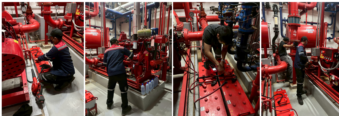
ภาพที่ 3-17 ห้องเครื่องสูบน้ำดับเพลิง และการตรวจสอบระบบ Fire Pump
