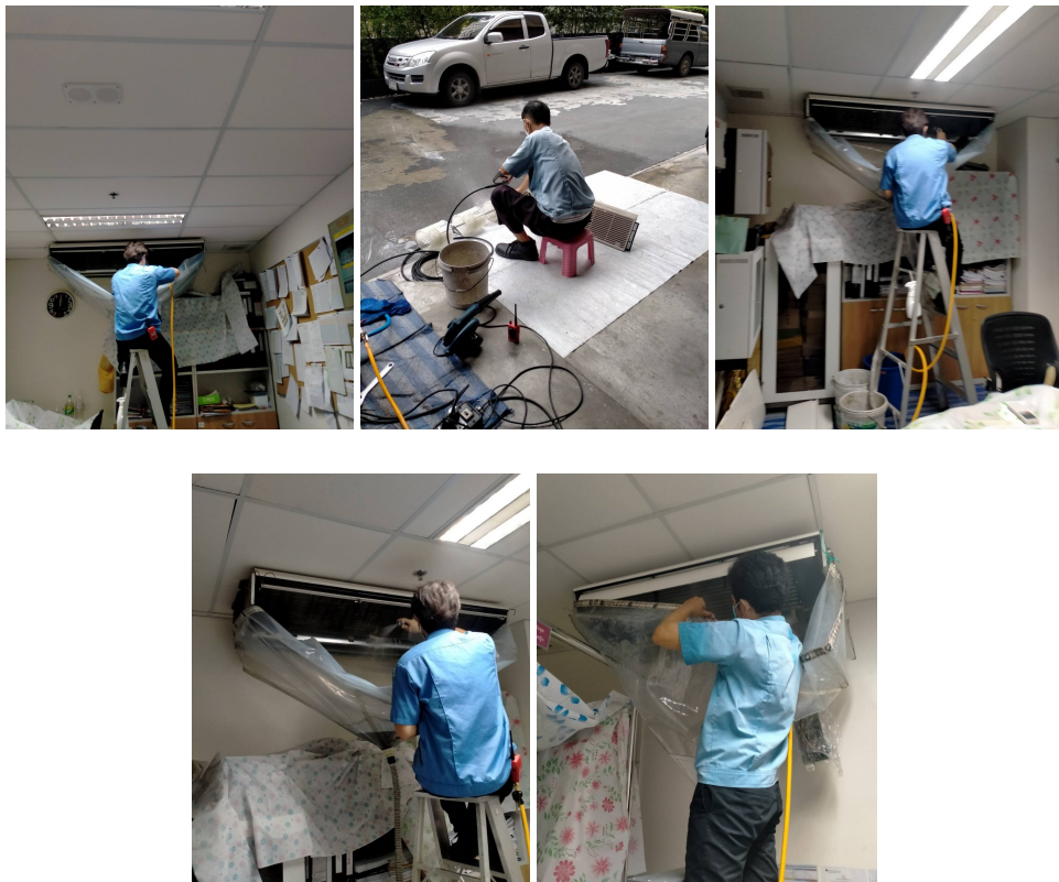
ภาพที่ 3-42 ล้างเครื่องปรับอากาศภายในอาคาร
