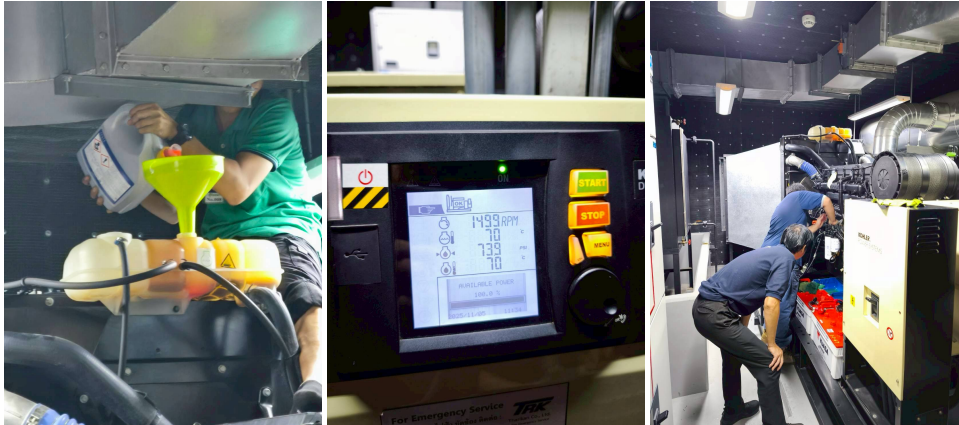
ภาพที่ 3-15 ห้องเครื่องระบบไฟฟ้าฉุกเฉิน และการตรวจสอบระบบไฟฟ้าฉุกเฉิน
