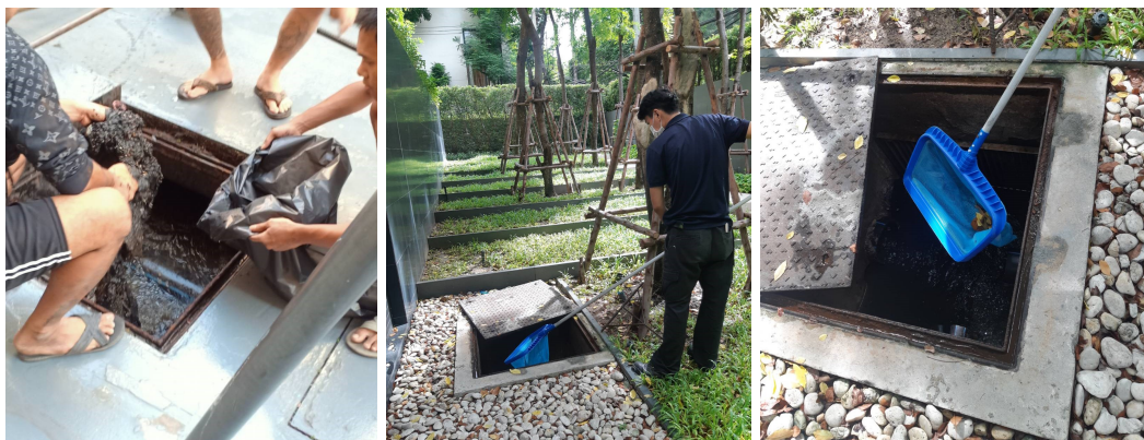
ภาพที่ 3-40 ขุดลอกท่อระบายน้ำและบ่อหน่วงน้ำ
